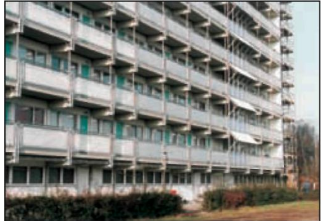
Varmforzinkede altanrækværker i højhusbyggeri.
